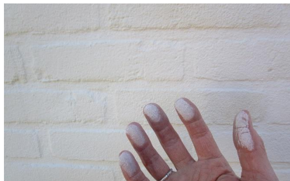
Poederig afgeven van sulfaatuitbloeiing
