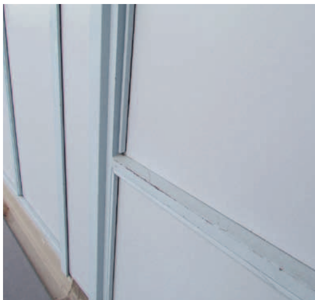
De situatie zoals die was: sterk verpoederd en toe aan een schilderbeurt. De transparante lak eronder is de onzekere factor: hoe zal die zich houden?
