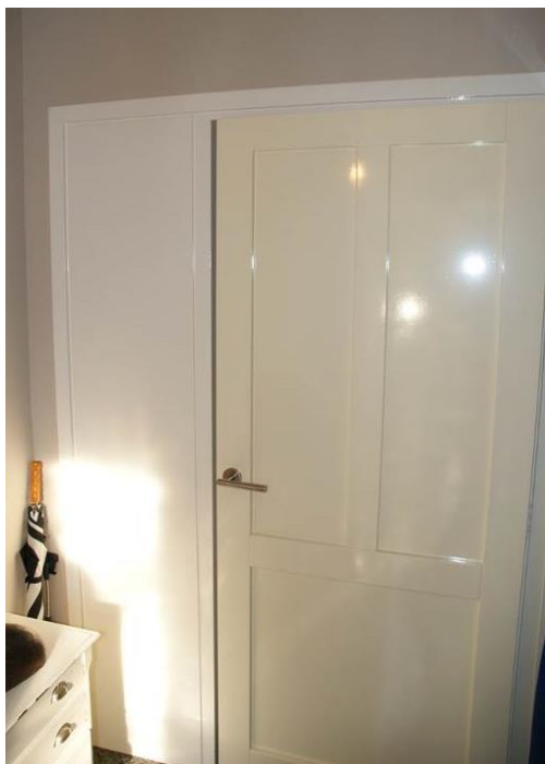
Een met alkydharsverf geschilderde binnendeur die is vergeeld.
