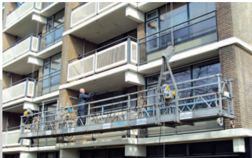
▲ Een medewerker van Smits Vastgoedzorg reinigt vanuit een hangbrug met een hoge drukspuit de betonnen geveldelen.
